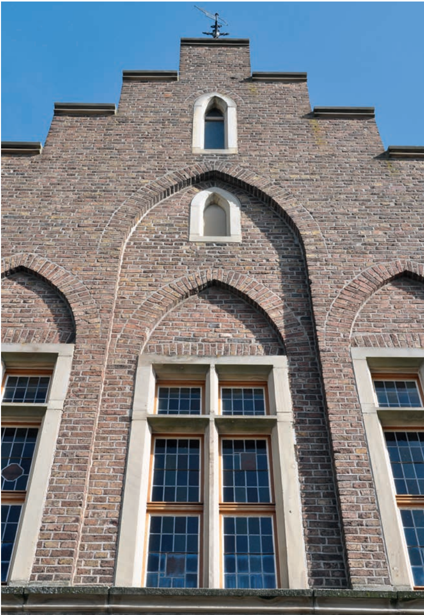
Die wirkungsvolle und kontrastreiche Akzentuierung der Ost- und Westfassade mittels Spitzbogenblenden geht auf Ernst Friedrich Zwirner zurück, Detailsicht der Westfassade (Foto Peter Biergans, Rheinbach)
