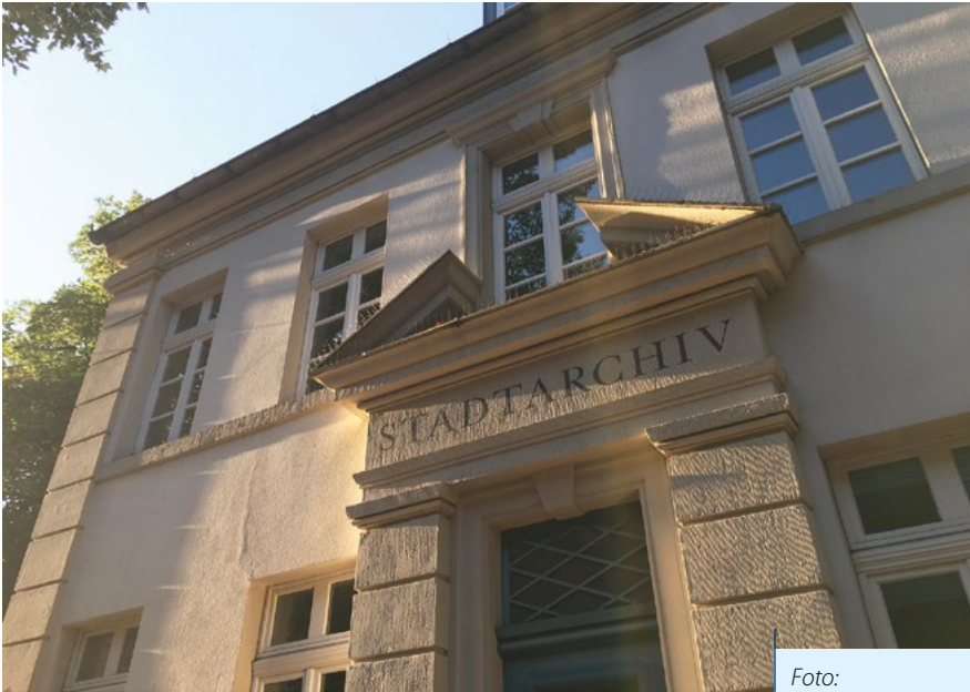
Foto: Frechen Archivgebäude
